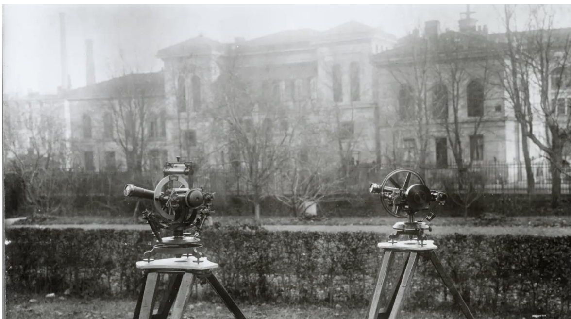
Figur 11. Teodolitter utenfor Norges geografiske oppmåling i Oslo (Statens kartverk, 1905 - 1920).
