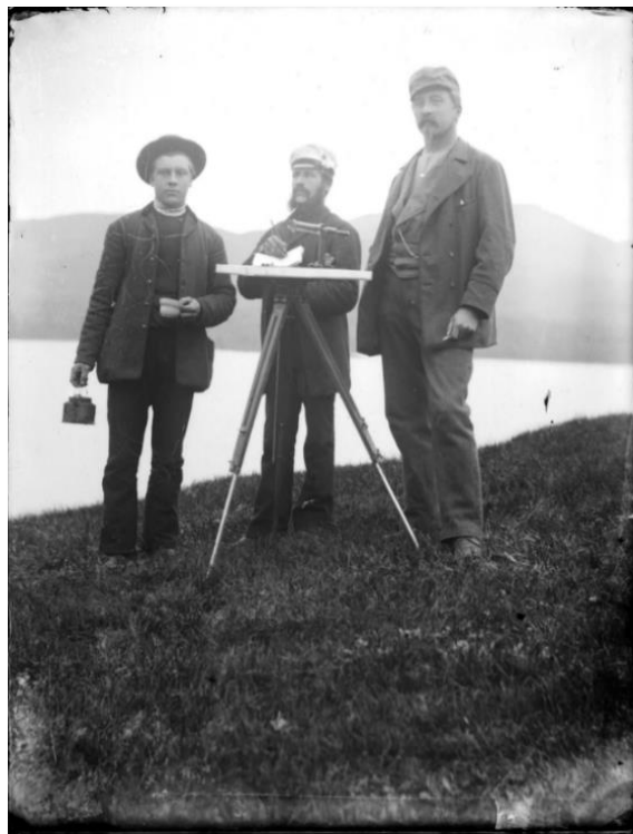
Figur 9. Tre menn arbeider ved målebord i felt (Ingulfsvand, 1859-1913).
