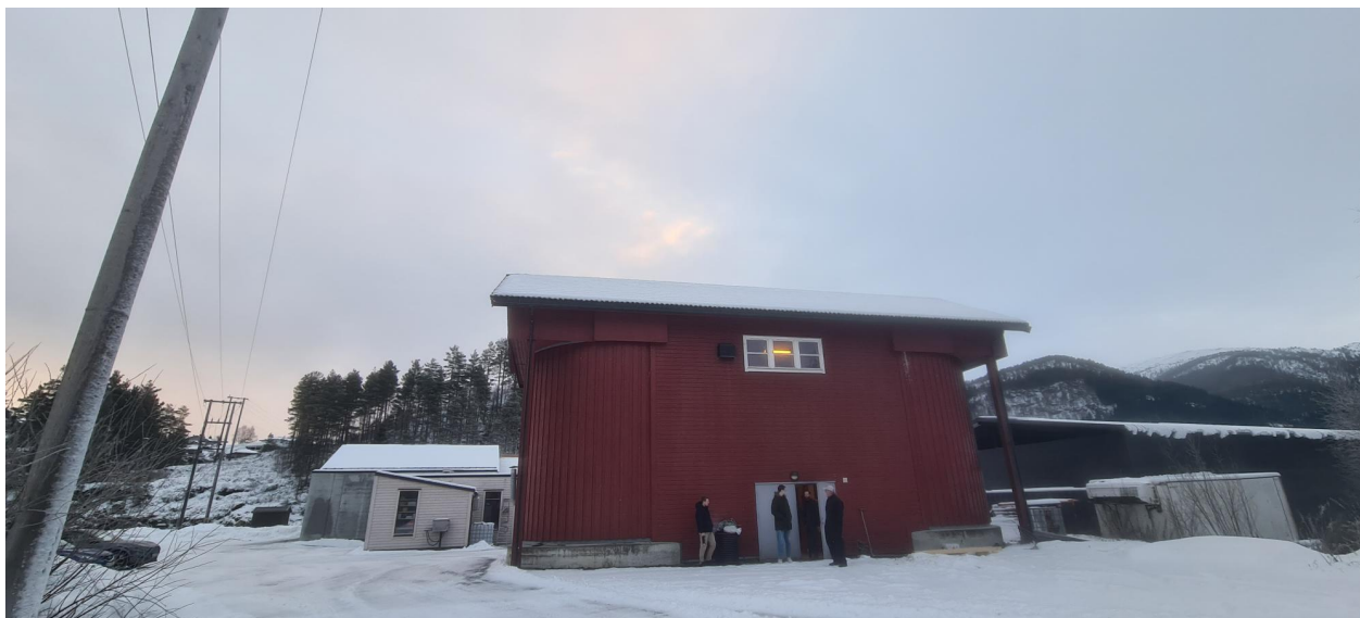
Figur 11.1: Første gjennomgangen av anlegget
