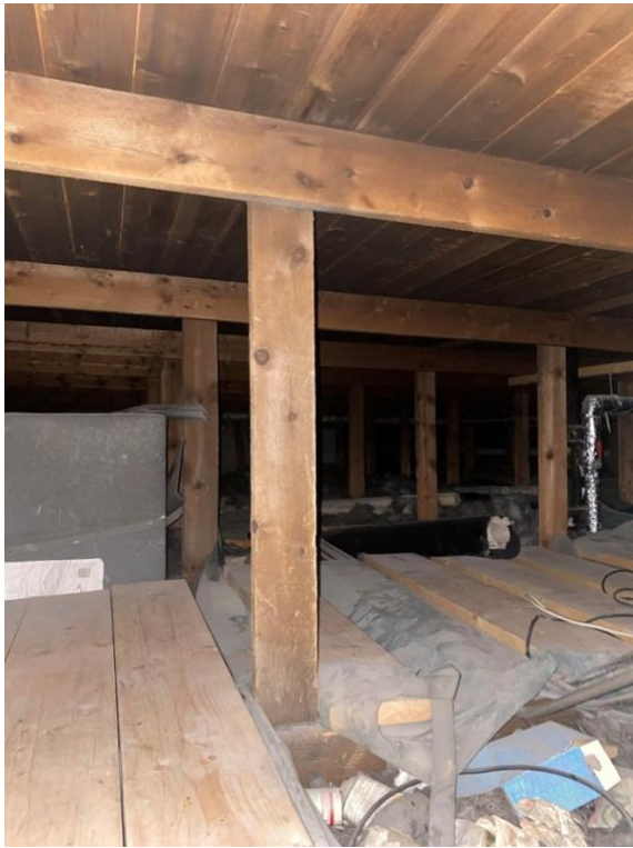
Figur 14: Privat bilde av takkonstruksjonen.
