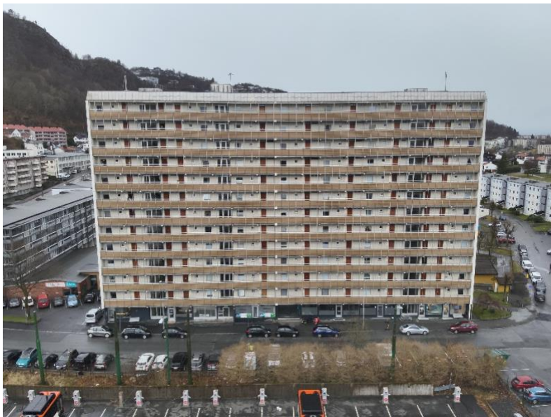
Figur 3: Viser høyblokken på Mannsverk fotografert med drone fra Vestbo.
