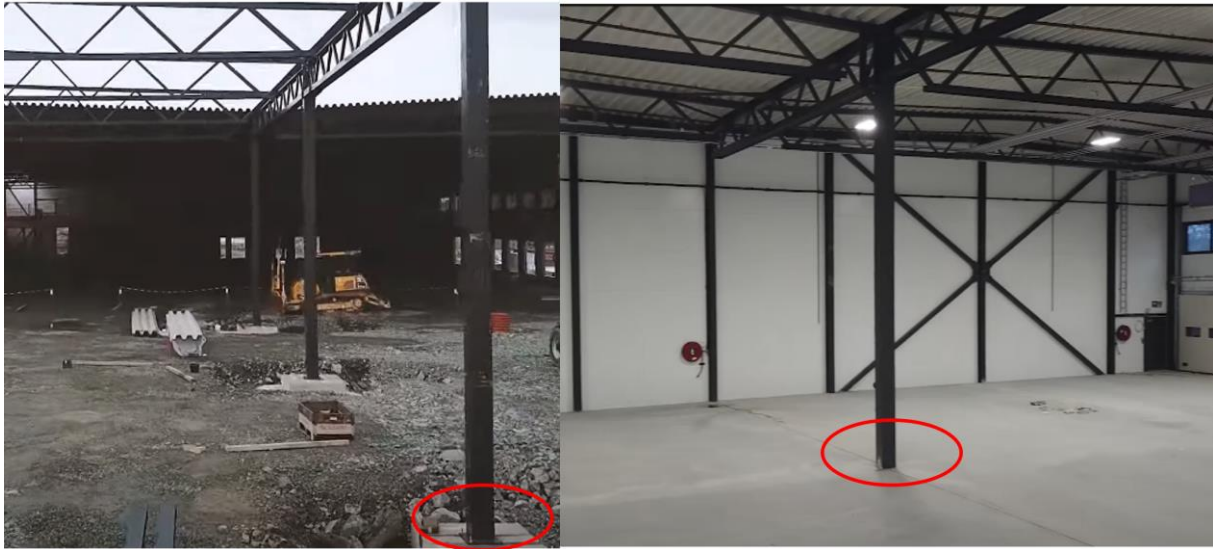
Figur 24 Illustrasjon, innfestning før/etter gulvstøp, skjermdump fra video [27].
