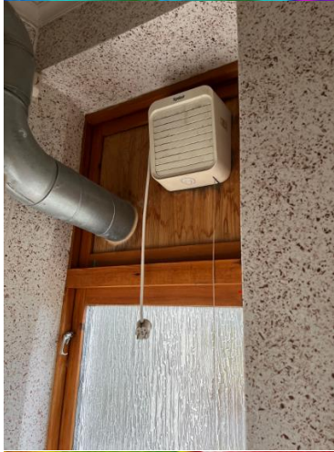
Vindu i murvegg, kjelleretasje, ved bad i tørkerom
