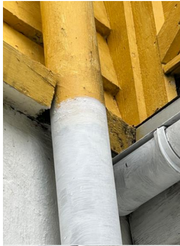
Sprekkdannelse/råte
