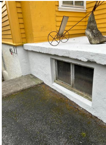
Tak over kjelleretasje på nordsiden
