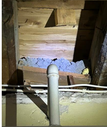
Etasjeskille kjeller/1. etasje
