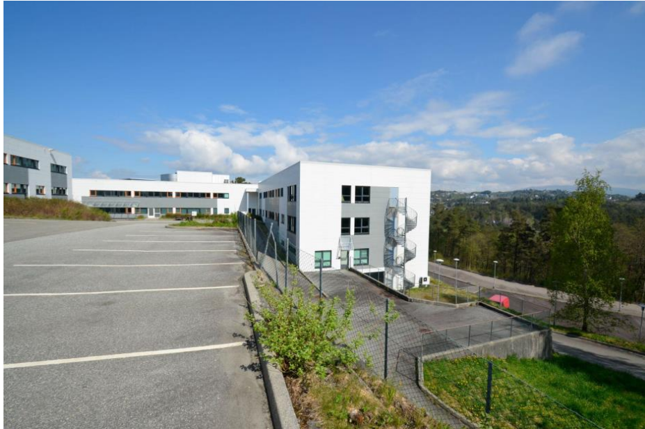
Figur 11. Sandsliåsen 46, Bergen 12. mai 2023.
