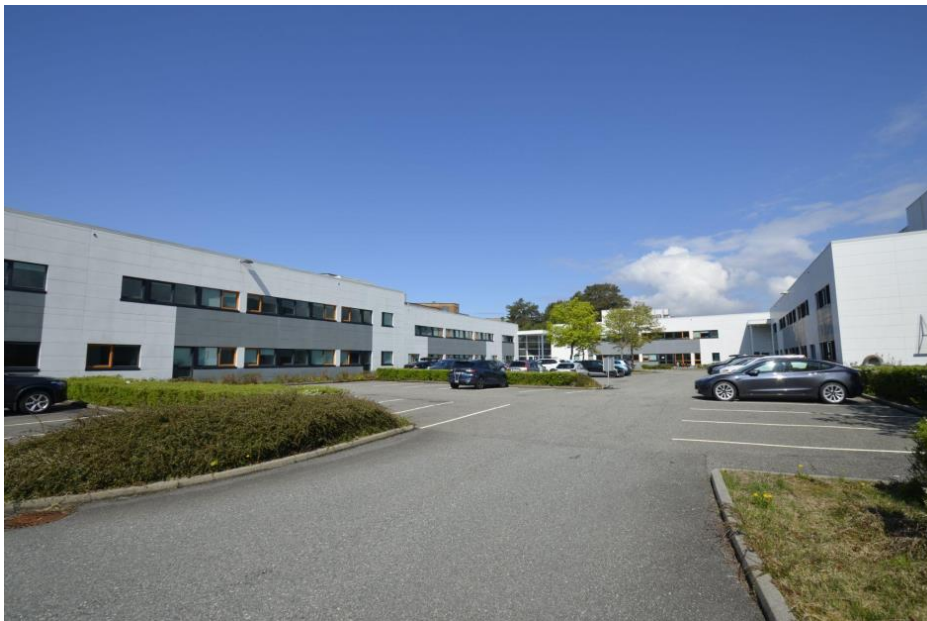
Figur 12. Sandsliåsen 46, Bergen 12. mai 2023.
