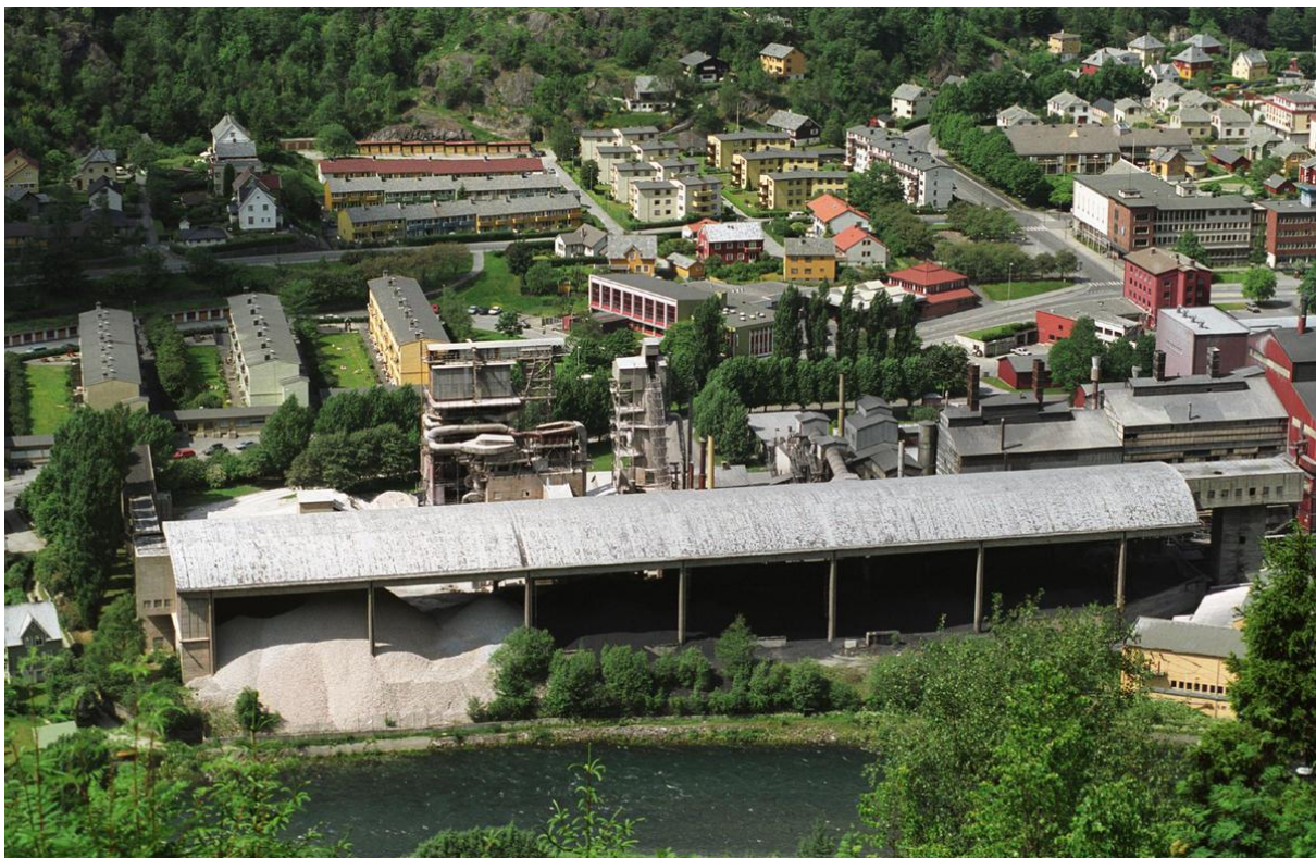
Figur 11: Skalltaket i Odda (Kraftmuseet, 2016)
