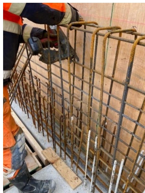
Bilete 1 – Armeringsjern som blir bunde saman med ei bindemaskin, Foto: Erlend Bø
