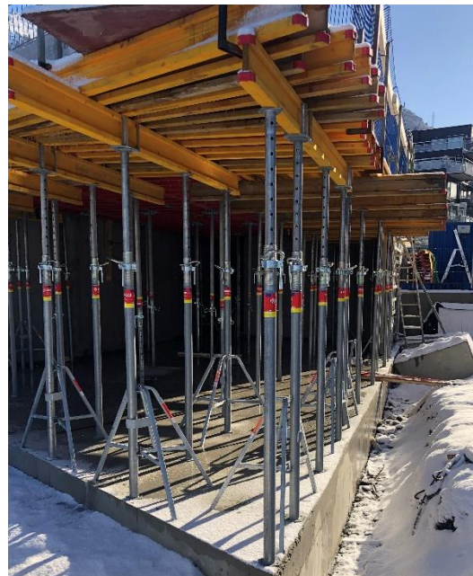
Bilete 2 – Forskaling av plasstøypd dekke med støtter, Foto: Erlend Bø
