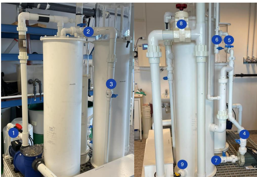
Figur 16 - Nummerert oversikt over ventilene i TMC2500.
