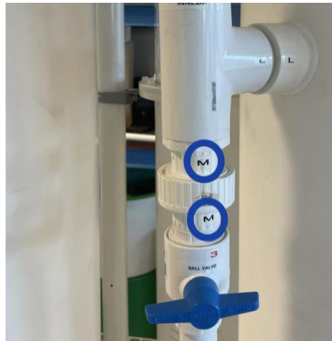
Figur 12 - Markering på rør
