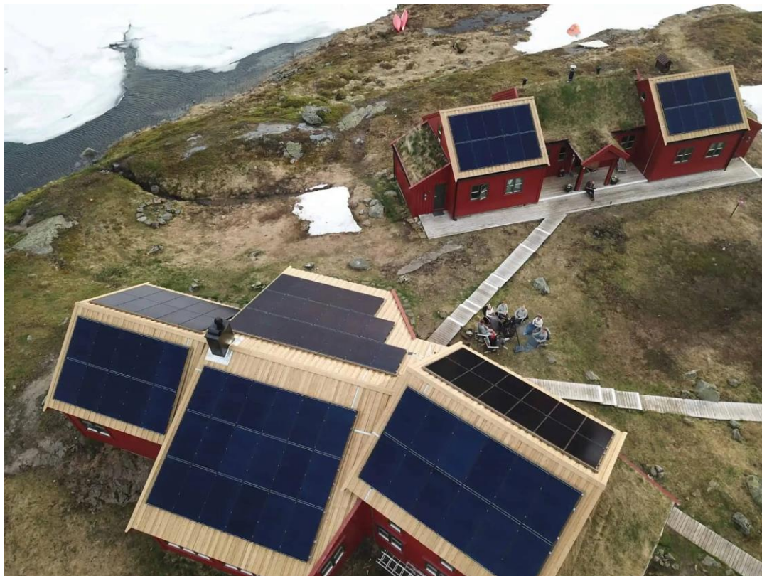
Figur 16 - Takmonterte solcellepanel sett ovenfra. (Foto av Kverneland Energi.)
