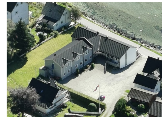
Figur 28: Havlys B&B er et overnattingssted med servering, scene og selskapslokale
