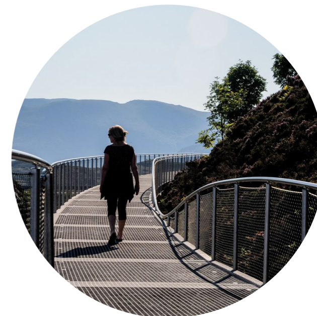
Figur 53: Rister på påler reduserer inngrep i sårbare natur. (Foto: Jan Andersen, Statens Vegvesen, u.å.).
