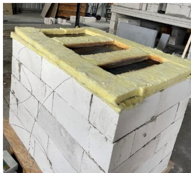
Figur 3-3: Isolasjon plassert over stålplater
