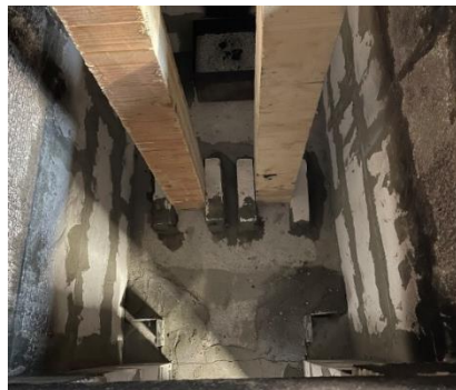
Figur 3-9: Plassering av prøvestykkene midt i rommet, sett gjennom takåpningen.
