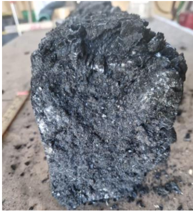
Figur 5-11: Forsøk #2, søyle V3: Øvre del av søylen (70-80 cm)
