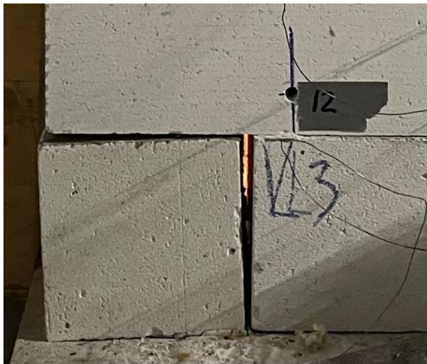
Figur 4-8: Hull mellom blokker ved søyle V3
