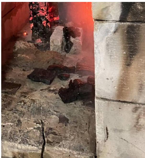
Figur 5-11: Delaminering i forsøk #18
