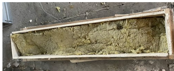
Figur 3-20: Boks med innvendig isolasjon over søylen
