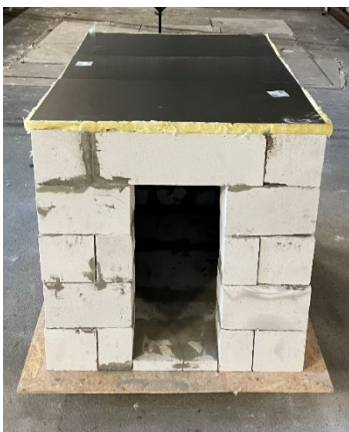
Figur 3-2: Stålplater på toppen av brannrommet
