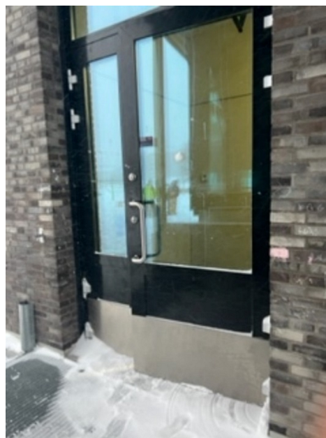
Figur 11 Teglverket skole- Utenfor rømningsdør
