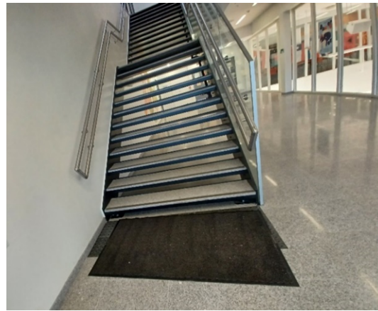
Figur 49 Veitvet skole: Innvendig trapp
