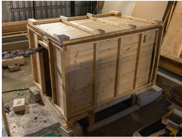
Figur 19: Ferdig montert halv skala ISO-rom. Åpninger mellom tak og vegger ble forsøkt tettet med tape.
