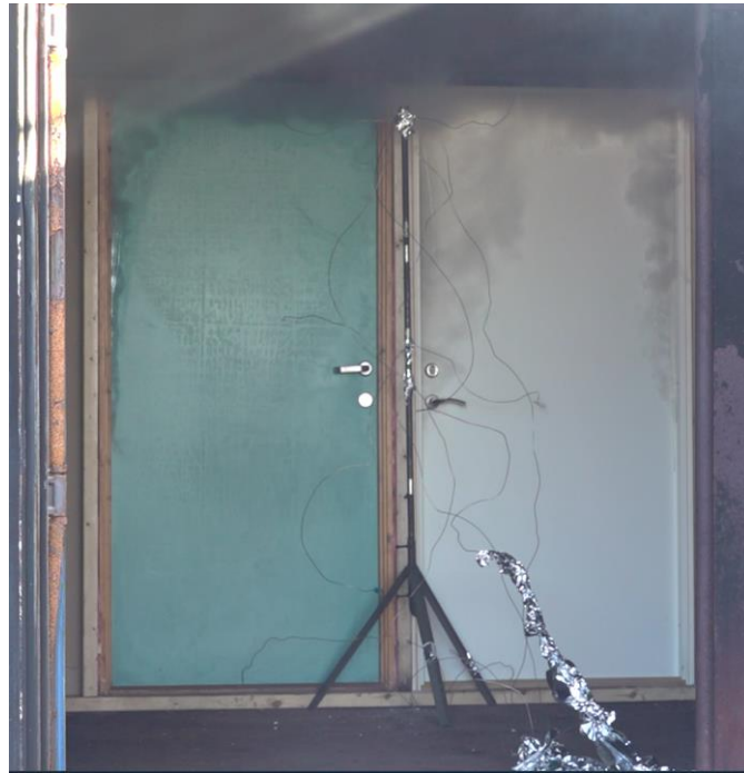
Figur 20: Viser situasjonen på uekspontert side 5 minutter etter brannstart.
