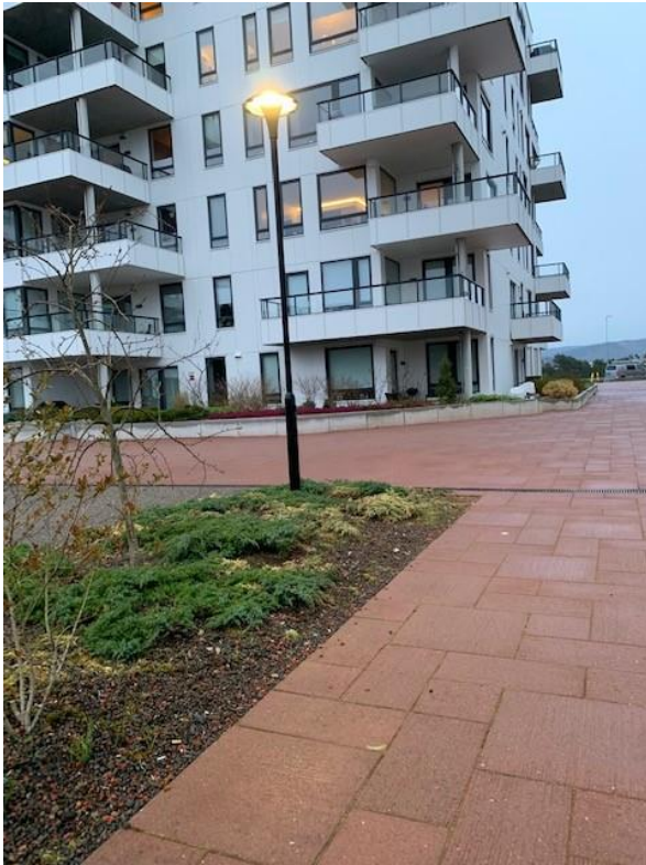
Figur 48: viser belysning i felles uteoppholdsareal på Sandslimarka (privat foto)
