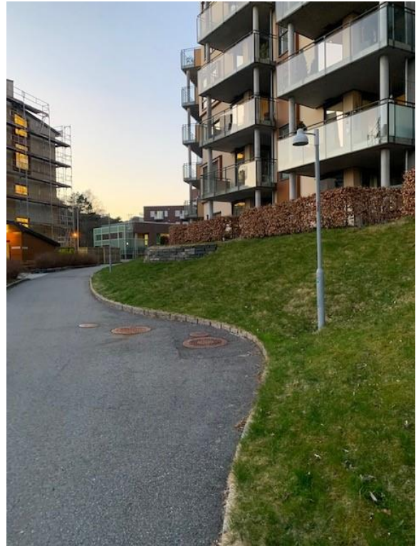
Figur 45: Viser belysning langs veien i Shetland-Larsens vei (privat foto)
