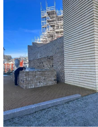
Figur 50, viser teknisk infrastruktur, privat bilde
