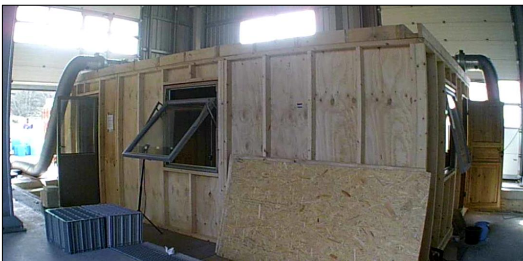
Figur 15: Utvendig bilde av forsøksboligen.
