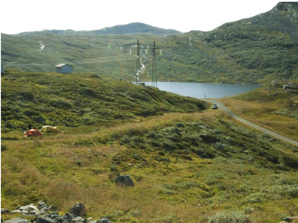
Figur 5 Foto av røyrgata frå 2021. Foto: Vilde Stensland Vinje
