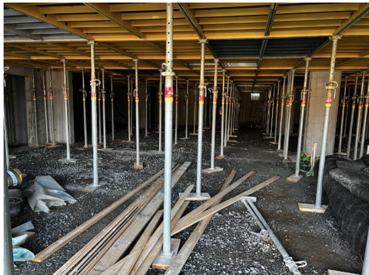
Figur 10. Stempling av systemforskaling i parkeringskjeller. Hentet fra: Privat foto.
