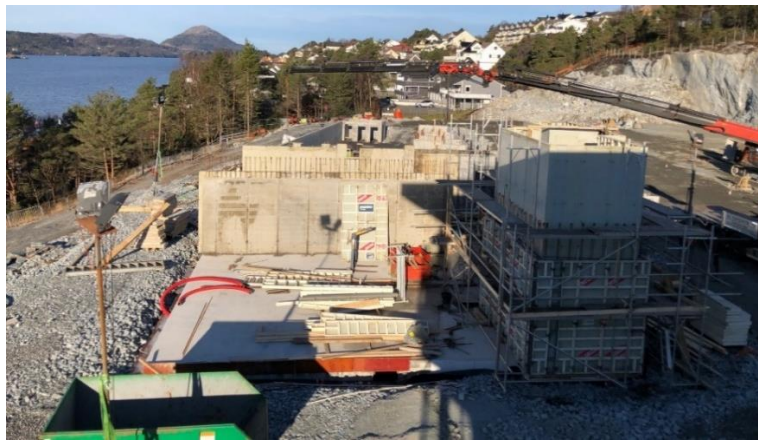
Figur 3. Oppføring av skivevegger og heissjakt i B6. Hentet fra: Privat foto.
