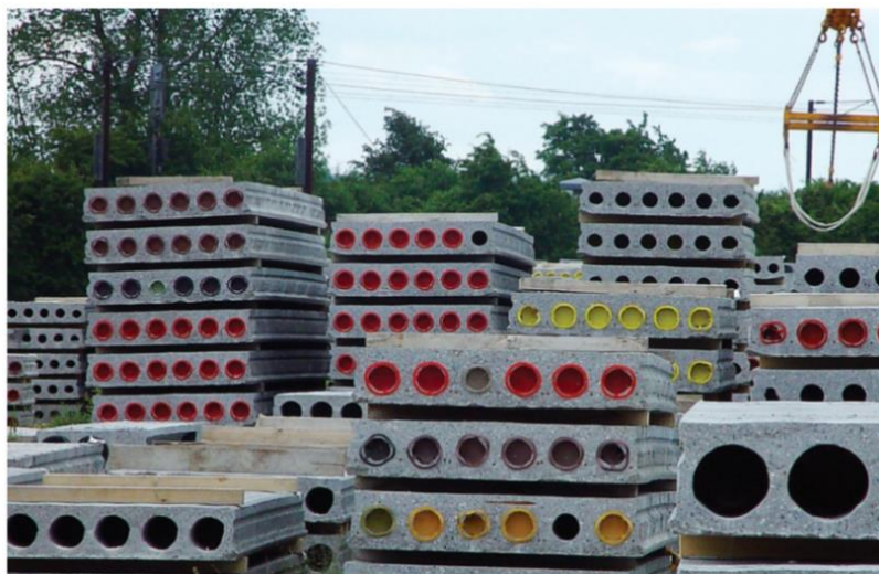
Figur 6. Hulldekker klar til montering. Hentet fra: Betongelementboken bind A 7.1 [13].
