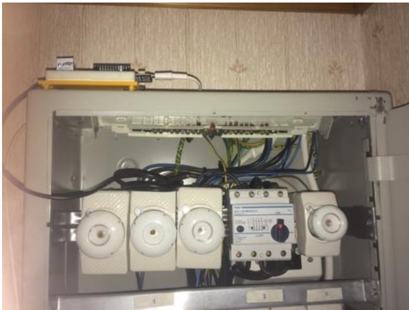
Bilde 3.3.1 Arduino mkr 1010 og temperatursensor DS18B20 testes i ett sikringskap
