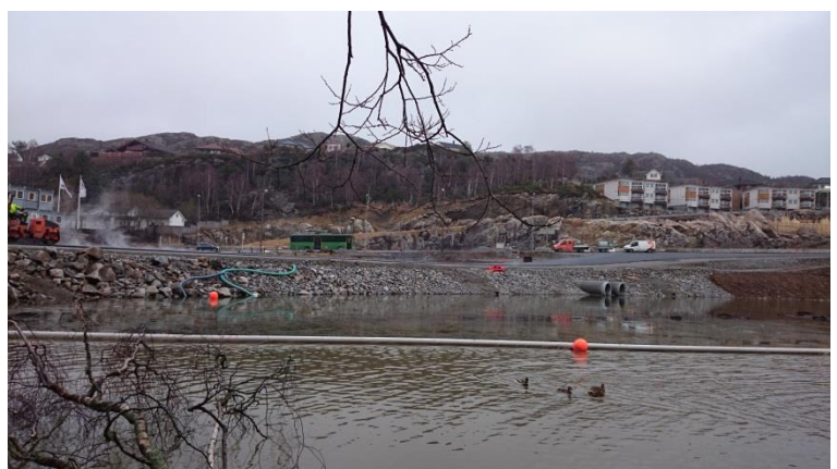
Figur 24: Siltgarden utlagt i Førrestjørn (Fotograf Sunniva Wollt-Vindedal).
