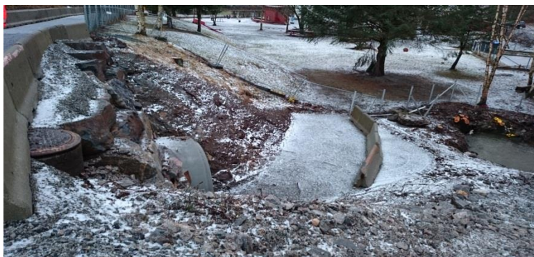
Figur 32: Midlertidige undergangen for myke trafikanter (Fotograf Sunniva Wollt-Vindedal).
