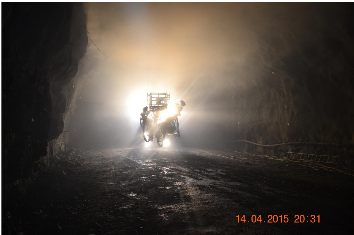
Figur 30: Arbeid i tunnelen (Fotograf Steinar Rullestad, SVV).
