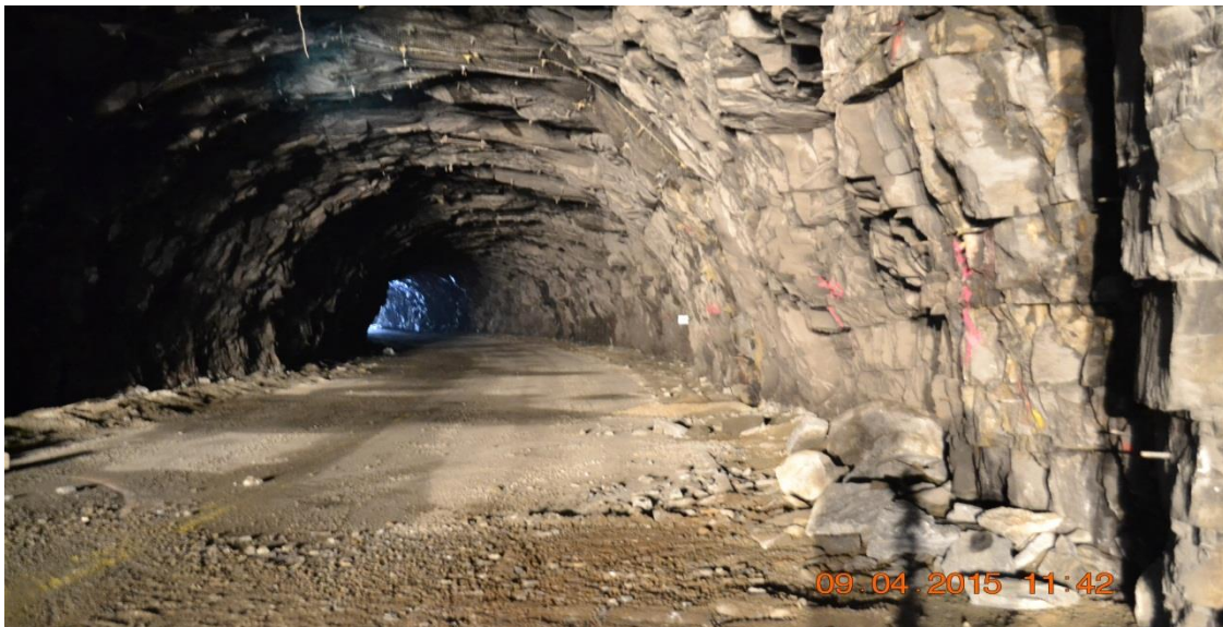
Figur 29: Tunnelen under utbygging (Fotograf Steinar Rullestad, SVV).
