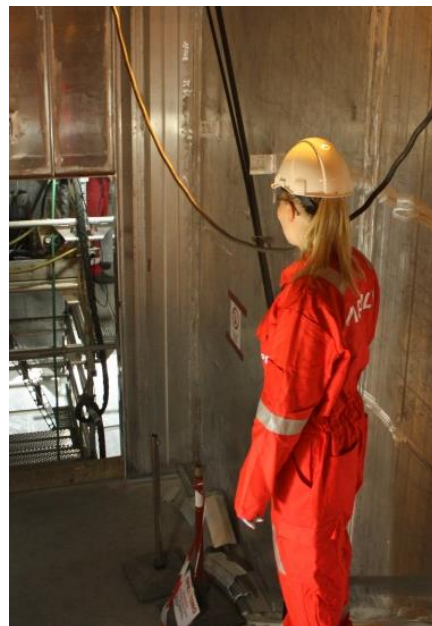
Bilde 6: Blokkering av rømningsvei
