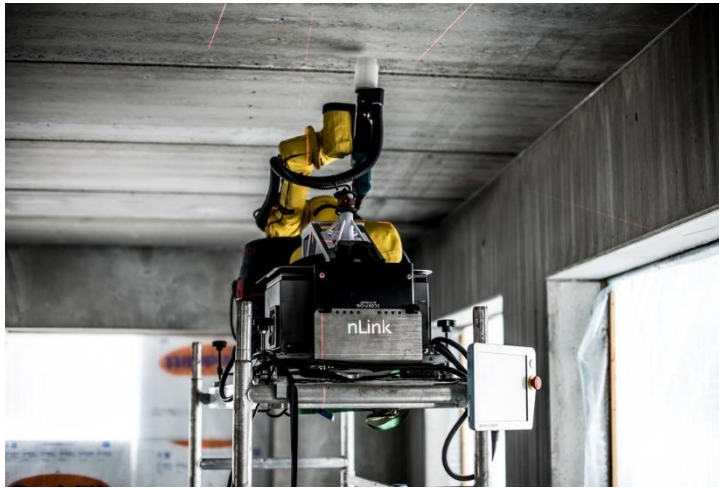
Figur 3: nLink sin borerobot i aksjon
