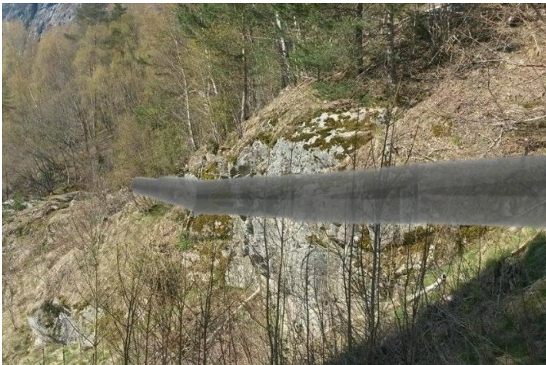
Figur 34. Utløpsrør sett fra eksisterende adkomstvei.
