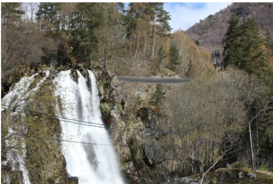
Figur 33. Utløpsrøret sett fra broen over Fardalselvi på riksvei 55.
