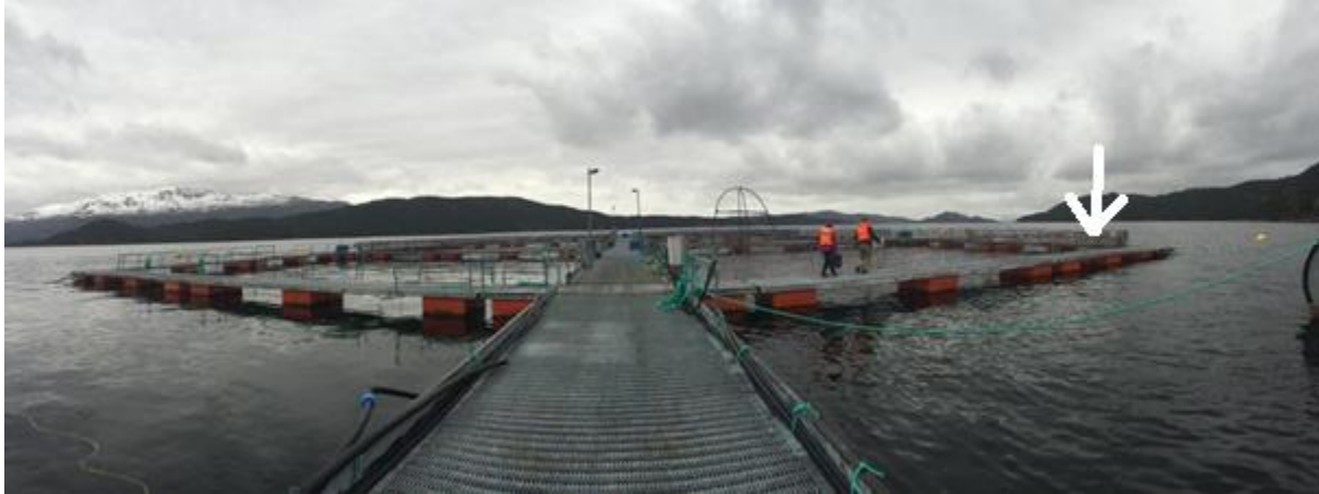
Figur 3: Oversiktsbilde av stasjonen på Seljeseth. Hvit pil markerer lokasjon av rigg
