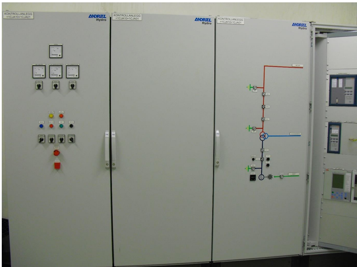
Figur 1 Typisk kontrollanlegg i ein kraftstasjon.
