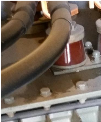
Figur 29 Oljelekkasje
