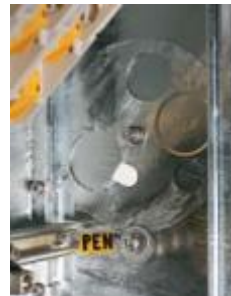
Figur 16 Opning til provisorisk kabel [36]
