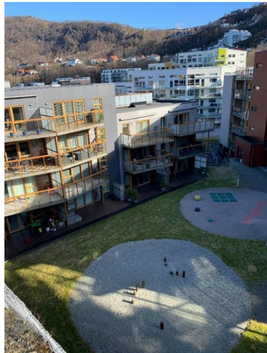
Figur 35: Viser fasade med ti meter buffer. (Privat foto)
