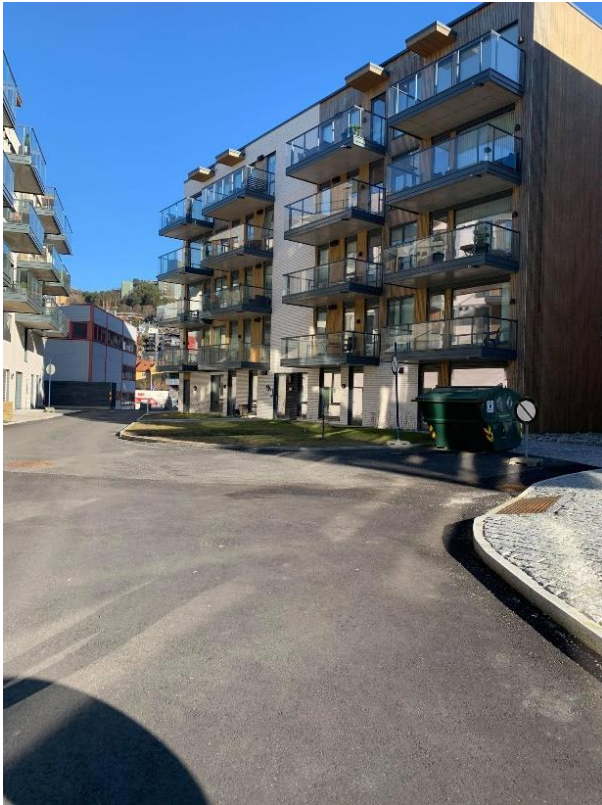
Figur 44: Viser fasade med ti meter buffer. (Privat foto)
