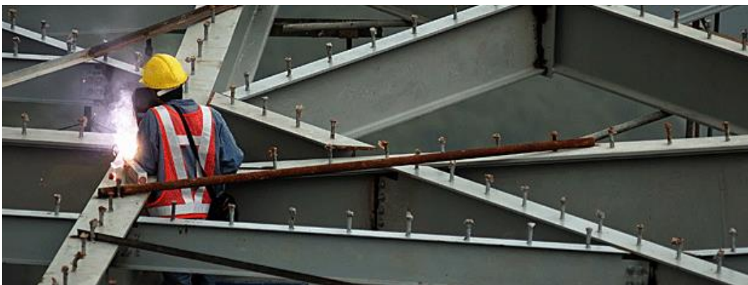
Figur 4: Stål på byggeplass [19]
