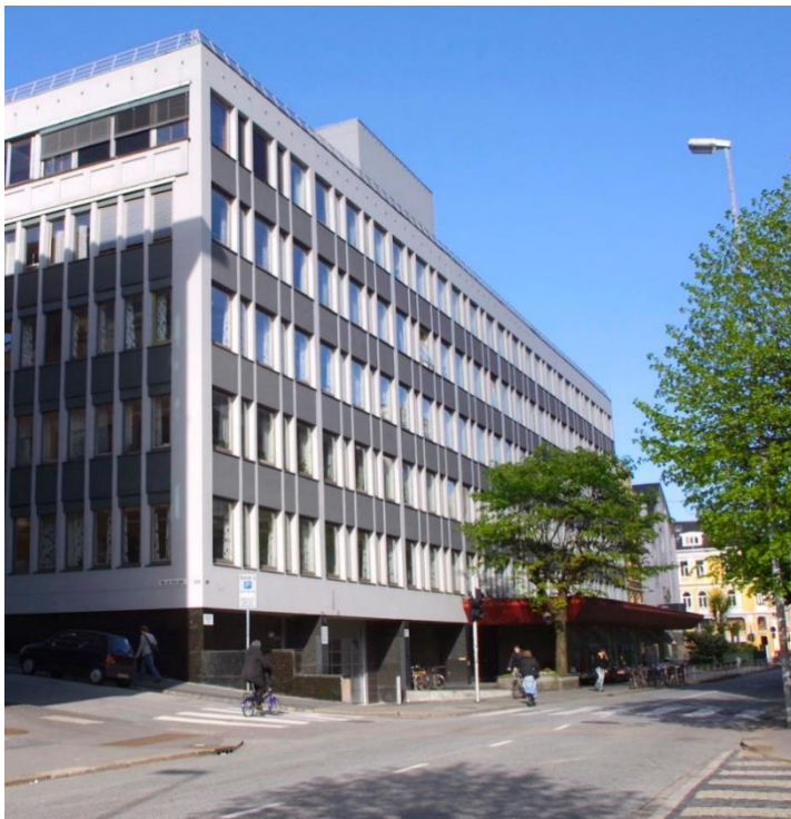
Figur 15: Slik så bygget ut før arbeidet med rehabiliteringen startet. Foto: UiB
