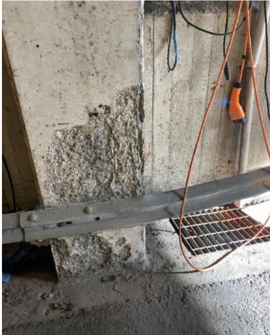
Figur 11 - Brannskadet betongsøyle
