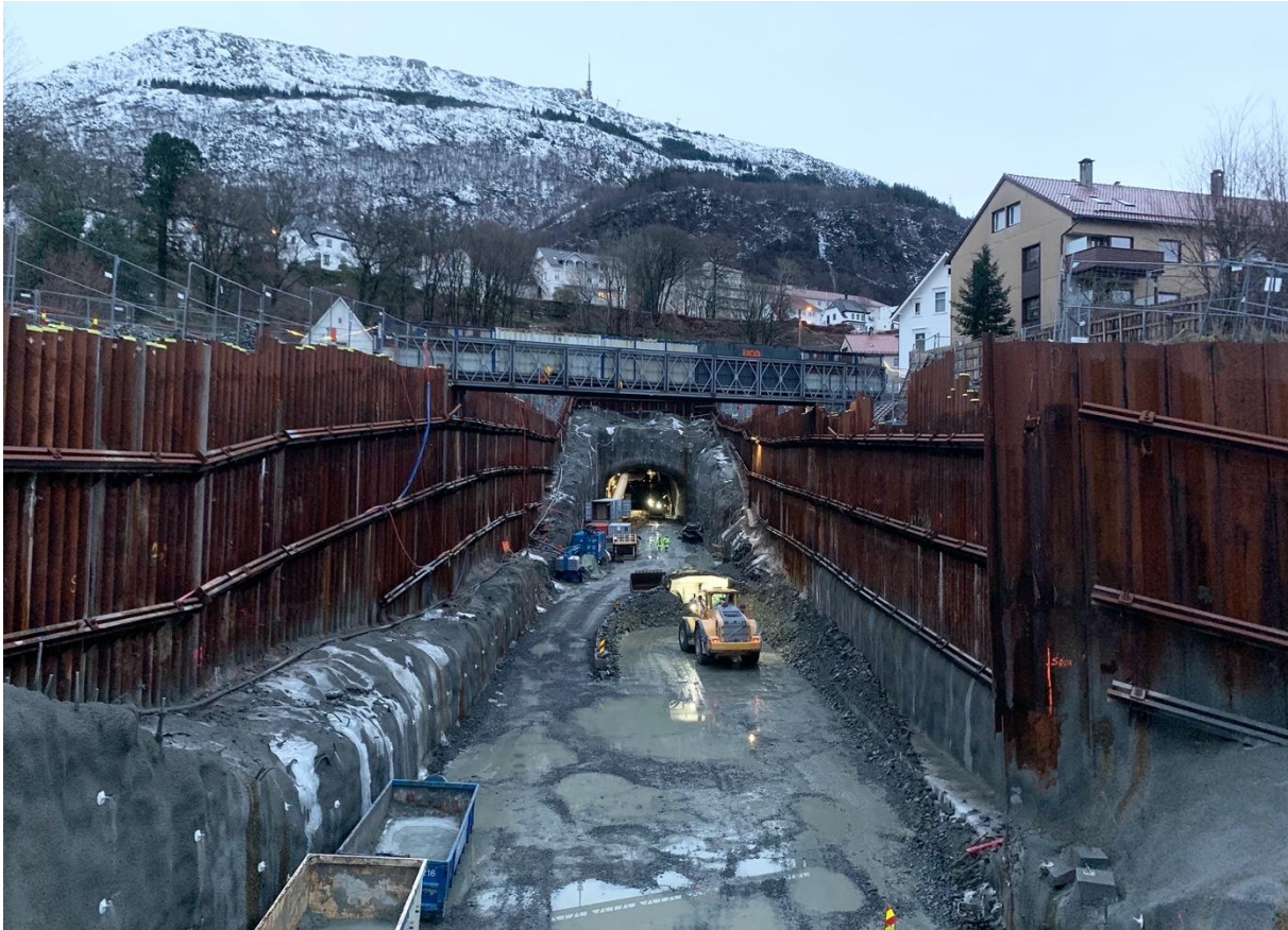
Figur 5: Bilde fra byggegropen på d12. Bildet er tatt 14.03.2021.
