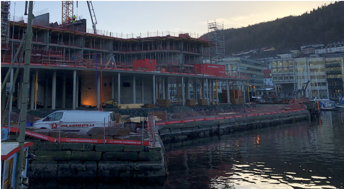
Figur 54 Natursteinsmur ved bygging av Moxy Bergen [48].
