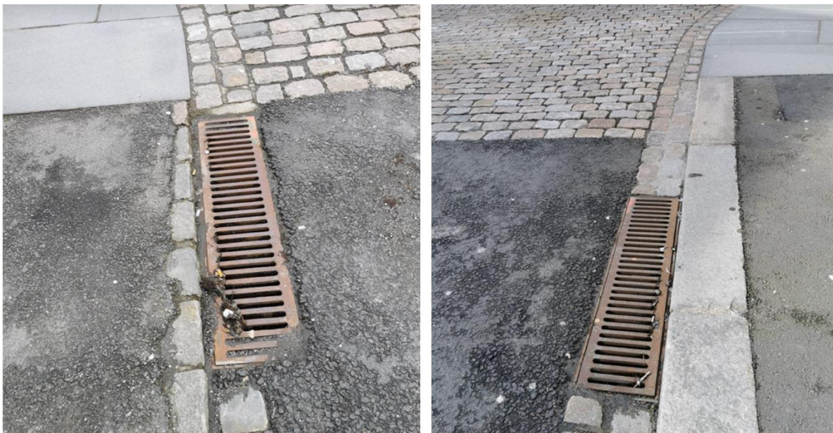
Figur 17 - Ristsluk på hver side av Øvre Korskirkeallmenningen oppstrøms for krysningen med Kong Oscars gate, privat
