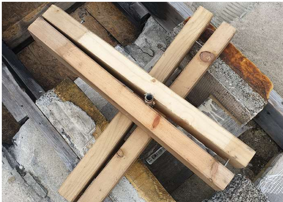
Bilde 6 - Festing av røret på taket
