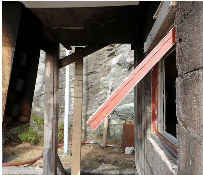
Bilde 2 - Vindu installert i forsøk # 3 med 45 graders åpning
