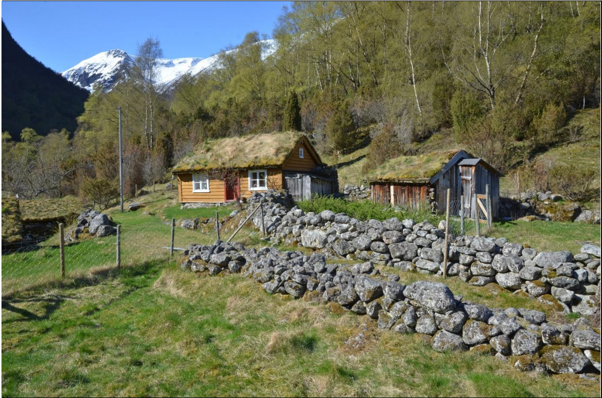
Figur 29. Husmannsplassen Halabrekka med stovehus, bod og steingôte. Elles står det både høyløe, kornbrot, kyrfjøs og sauefjøs i tunet.
