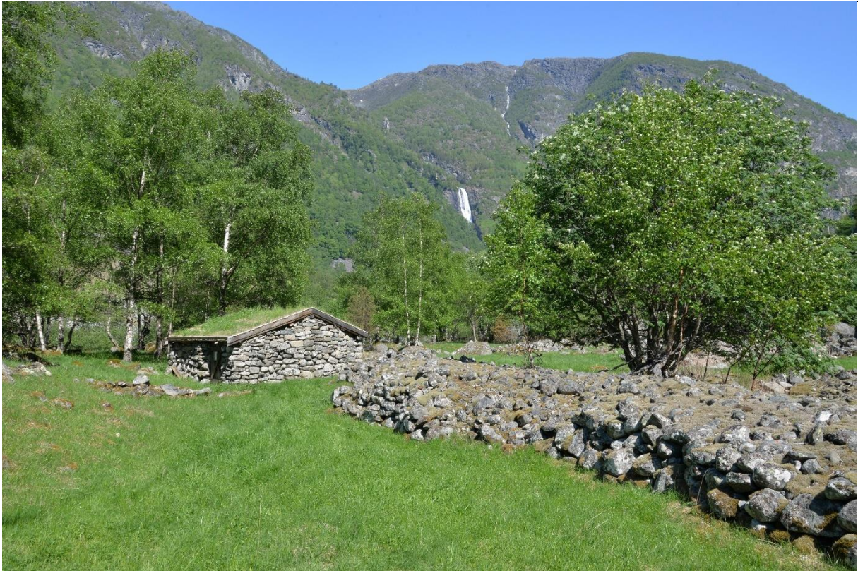
Figur 62. Hønjahagen med restaurert steinfjøs, høyløe, rydningsrøyser, vatningsveiter, slåttemarker og haustingsskog.
