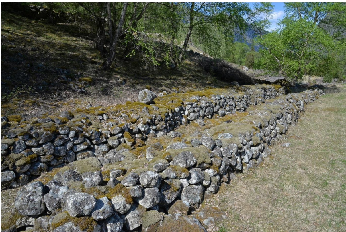
Figur 32. Tradisjonell buveg (gôte) og steinopplegg på Halabrekka.
