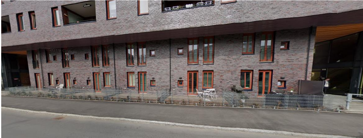
Figur 87. Fotografi fra Sjørengautstikkeren som illustrerer hvordan boligfortetting anbefales utført i planområdet. Her er attraktive og trygghetsskapende fasader sikret på gateplan. Hentet fra: Google Maps (2020).
