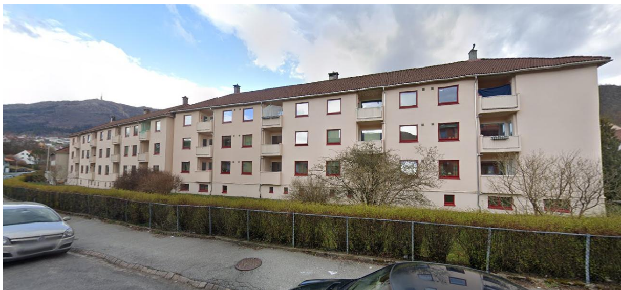
Figur 59. Fotografi fra Sletten, som på sin side viser unconstitutedness. Her er ingen innganger direkte koblet mot tilstøtende gate. Hentet fra: Google Maps (2020).
