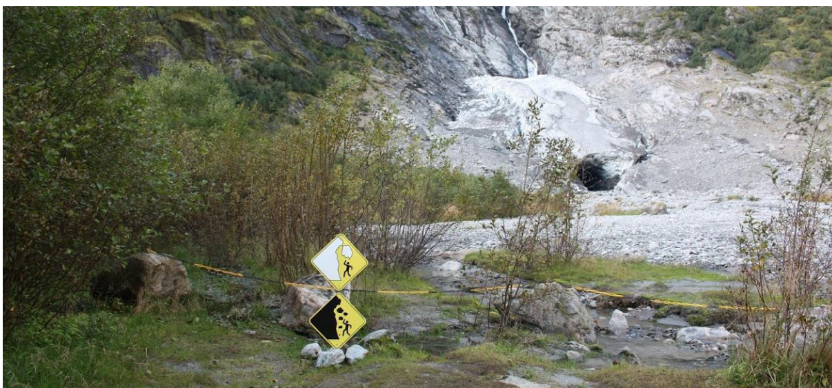
Figur 34: Sperringen ved utkikkspunktet består av en enkel kjetting og fareskilt.
