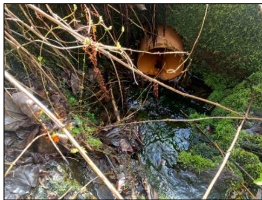
Figur 39: Vannføringen fra vannkanalen lagt i rør (foto: Marie Kristine Ødegård)
