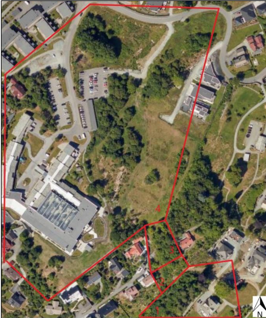
Figur 42: Planområdet delt inn i fire delområder (© Statens kartverk, Geovekst og kommunene, Midt-Hordaland skråfoto 2018)
