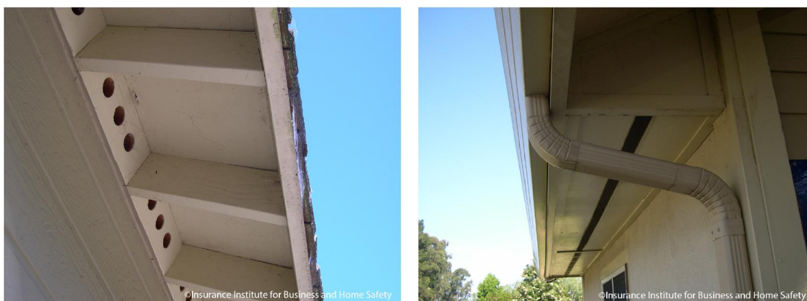
Figur 4.51 Tilluftsventiler: Åpen ventil i vegg (venstre) og takfotventil (høyre). Hentet fra [101], © IBHS
