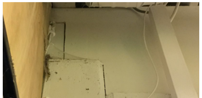
Figur 31: Bjelke fritt opplagt på betongsøyle i akse 7.
