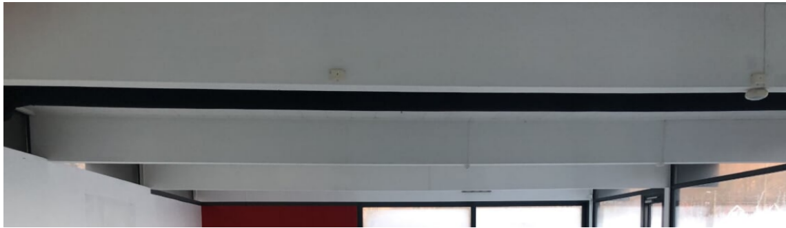
Figur 17: Limtrebjelkene i MB-auto. Bilde ble tatt på befaring.
