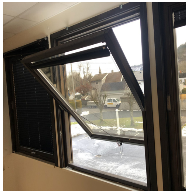
Figur 27: Midthengslet vindu. Bilde ble tatt på befarings.
