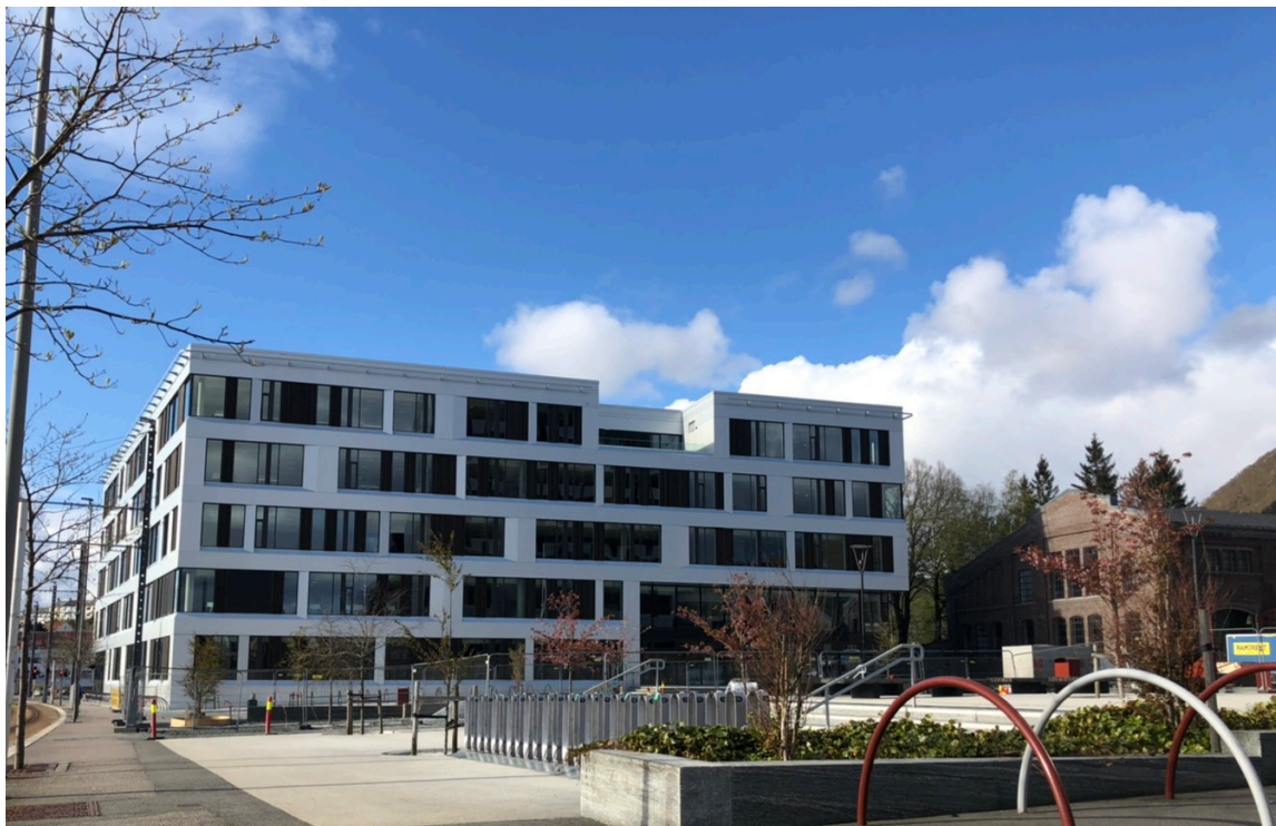
Figur 36: K2-bygget. Bilde tatt i forbindelse med oppgaven
