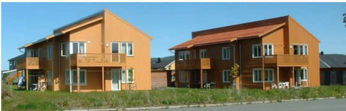
Figur 12: Til høyre gjenbrukshuset, til venstre ordinær bygget. Bilde hentet fra (Trondheim kommune, 2019).
