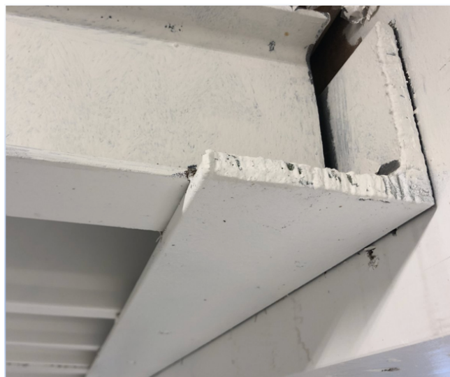
Figur 28: I-bjelke fritt opplagt på L-bjelke stål
