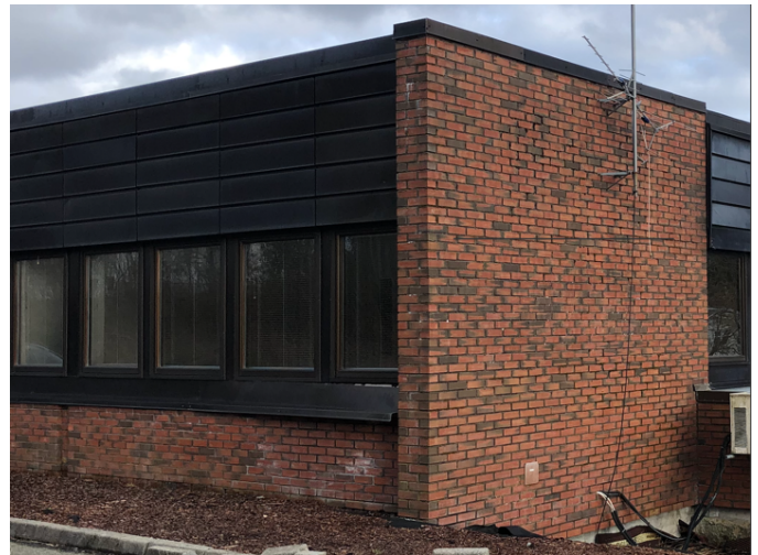
Figur 26: Noe kalk-eller saltutslag på fasadetegl
