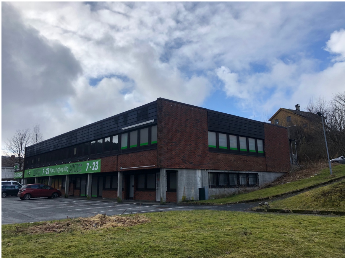
Figur 25: Fasade av bygget i Krokeideveien 13. Bilde tatt på befaring.
