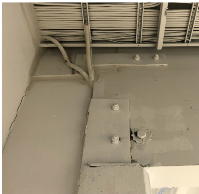
Figur 32: Knutepunkt sidebjelke og midtre bjelke i akse 6
