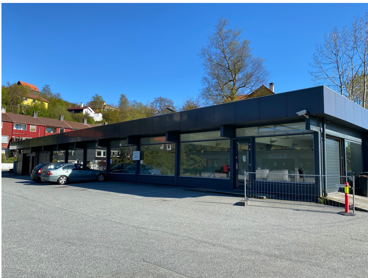
Figur 15: Foto av fasaden til MB-auto, tatt på befaring
