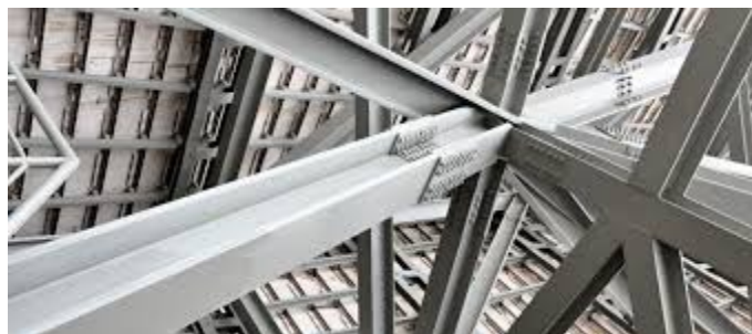
Figur 8: Stålkonstruksjon.. Bilde hentet fra (Byggogbevar, 2019).
