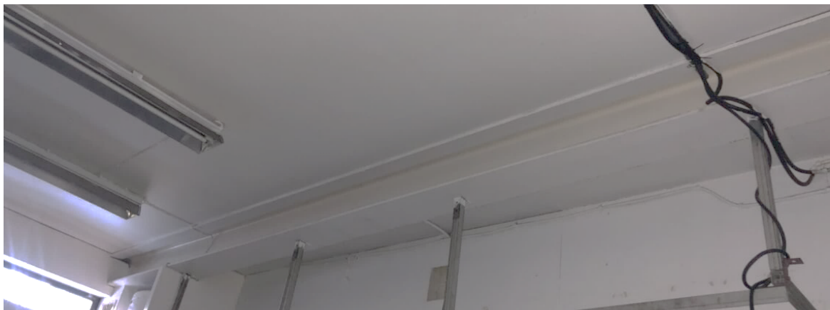
Figur 18: Stålbjelke i MB-auto. Bilde ble tatt på befaring.
