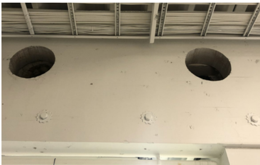
Figur 34: Utsparinger midtre takbjelke til ventilasjonsføring akse 5
