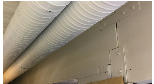
Figur 30: Innfestning mellom bjelkene i akse 7, skrueforbindelse
