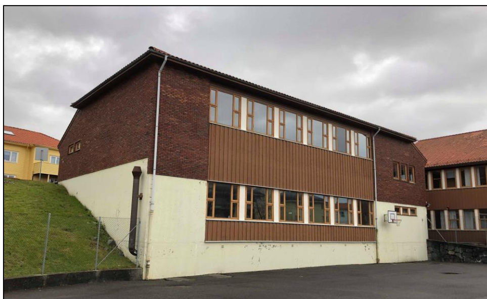
Figur 2: Bygget som står i dag, eget foto
