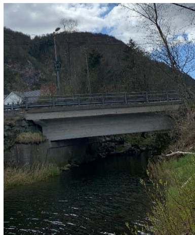
Figur 7: Søylene Sundsbrua (Foto: Privat)
