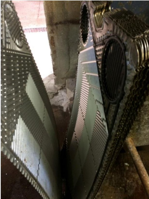
Figur 97 Vekslerplater etter rengjøring
