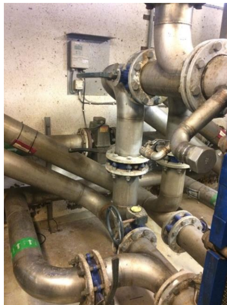
Figur 99 Reguleringsventiler til varmeveksler H2
