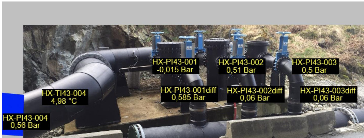
Figur 27 Oversikt over de tre silene. Hentet fra PI DuPont
