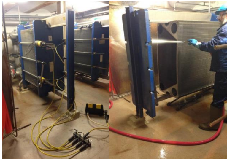
Figur 11 Spyling av varmevekslere. [18]
