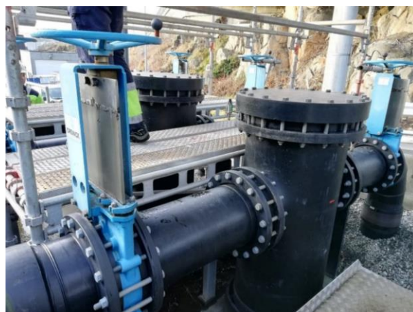
Figur 106 Knivventil til åpning og stenging for rengjøring av "strainer"
