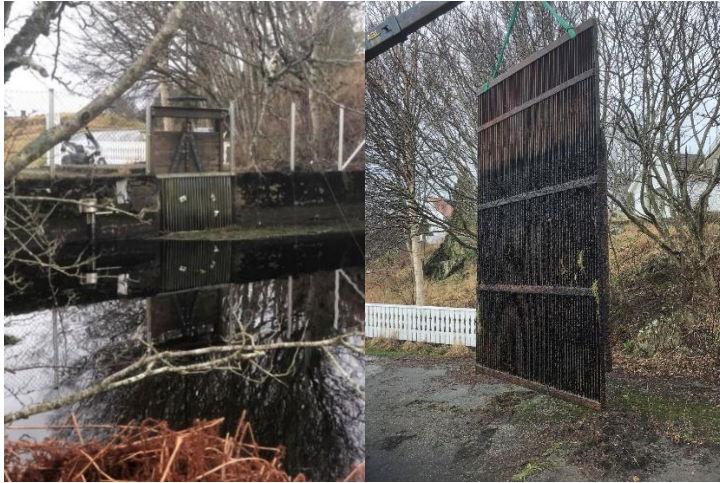
Figur 109 Rist ved Stemmen på inntaksledningen til DuPont
