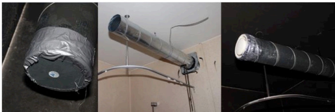
Figur 18: De ulike konfigurasjonene for avtrekksanlegget. Hentet fra [52]
