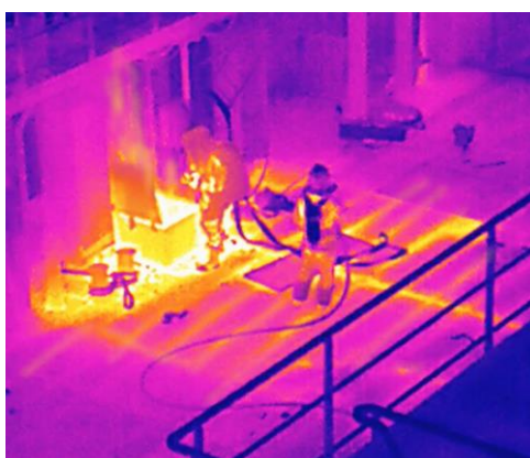
Figur 4-5 Oversiktsbilde fra MF Ytterøyningen tatt med IR-drone Kilde: Hentet med tillatelse fra [5]
