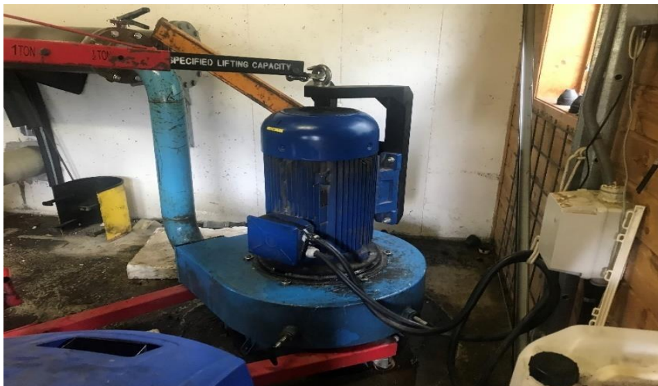
Figur 3.1: 37 kW Asynkrongenerator med turbin, Nedre Kvemma minikraftverk (foto: CompactHydro)
