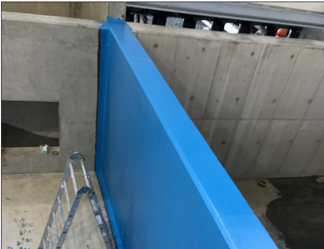
Figur 6 - Bilde fra Acrylicon Superimpregnering med porefylling - Bremnes Seashore avd. Trovåg
