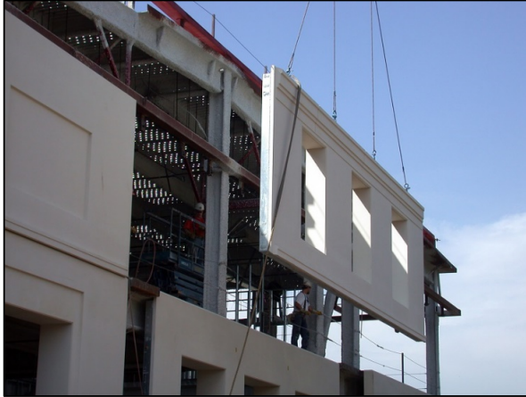
Figur 5 - Montering av fasade - Prefabrikkert betong [7]
