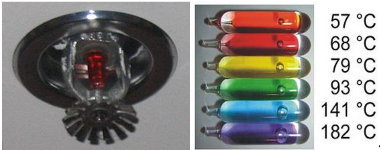
Figur 11-Takmontert sprinklerhode og sprinklerampuller[25]
