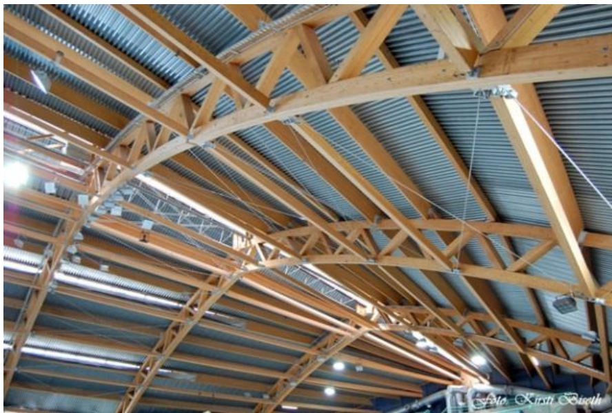
Figur 2-Limtrebjelker i Vikingskipet[5]
